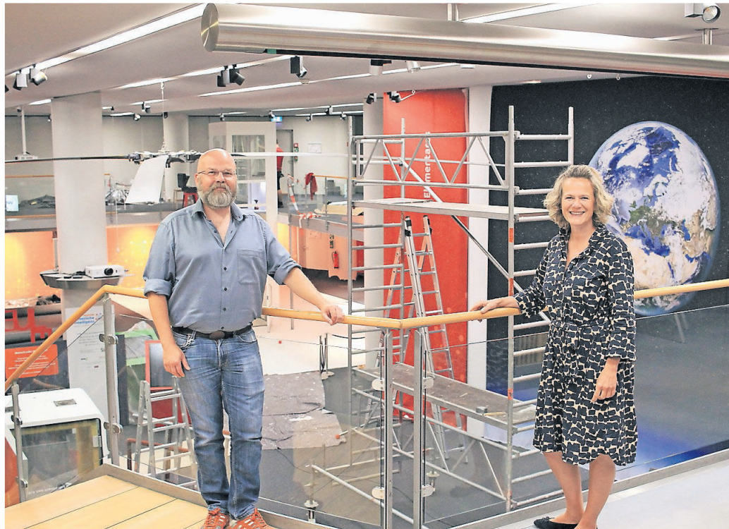
Auf der Baustelle: Kurator Ralph Burmester und Direktorin Andrea Niehaus während der Umgestaltung des Deutschen Museums Bonn zum Forum für Künstliche Intelligenz.
